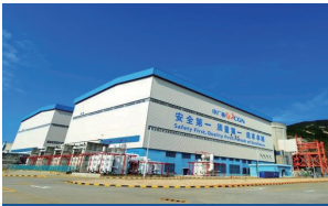
核电站智能巡检
