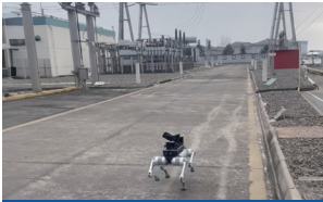
电网变电站检测
