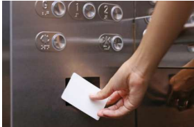
安装【刷卡系统】的电梯系统
