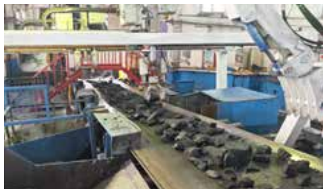
• 矿用皮带异物分拣机器人 (框架式 - 低速) 现场应用
