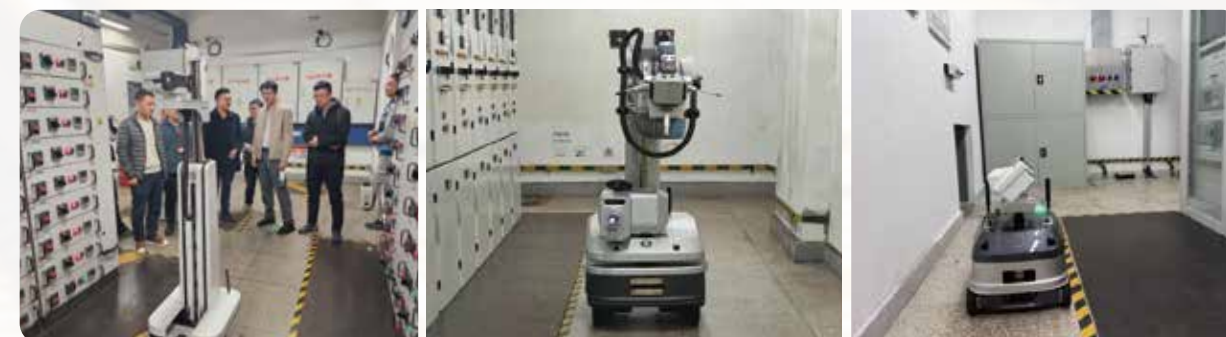
▲ 供电巡检机器人系列运用案例
