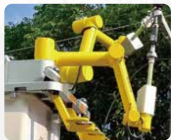
▲ 配网带电作业
