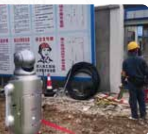
▲ 台区建设工程监理
