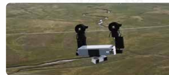
▲ 青海输电线路巡检
