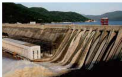
水库大坝巡检运维
