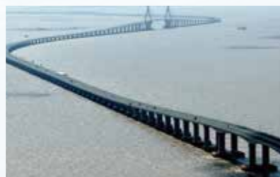
桥墩检测运维
