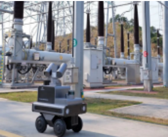
配网作业机器人
