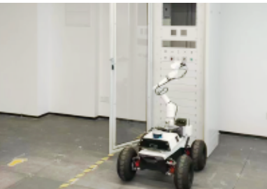
建筑电力作业
